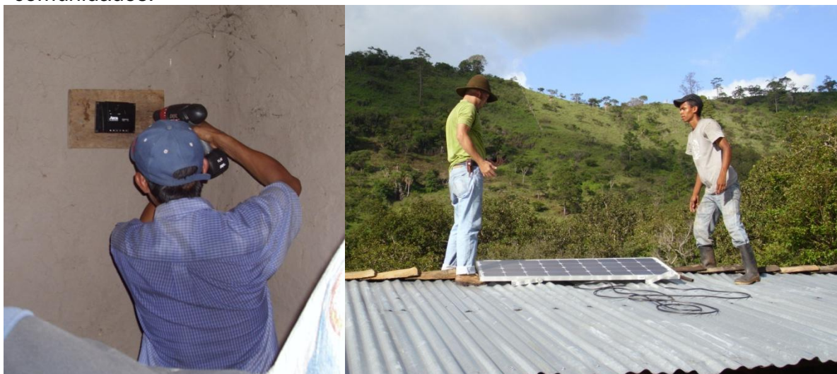
Izquierda: Líder comunitario instala un controlador de carga y a la derecha: técnico del MCN busca la orientación N-S (utiliza una brújula), acompañado de líder comunitario capacitado en instalación de sistemas PV aislados
